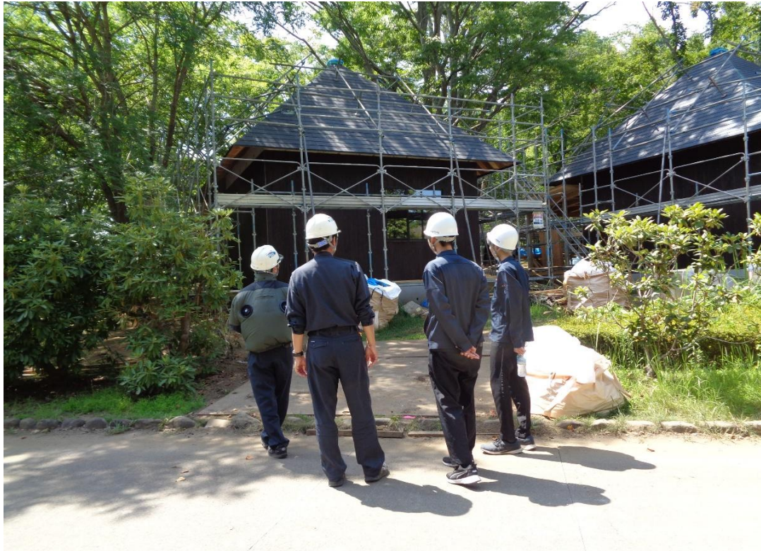
建築工事の説明
